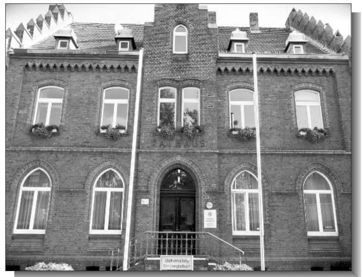
Nach Karneval sollen die Umbauarbeiten im Rathaus beginnen.
