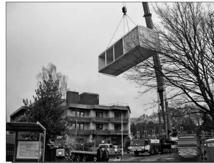
Gespannt warteten die Heimbewohner und viele weitere Interessierte am 3. Dezember 2008 auf das „Einschweben“ der ersten Räume für den Neubau des Altenzentrums. Foto: BE red.
