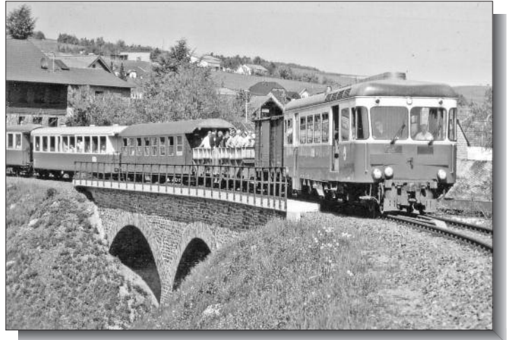
„Vulkan-Express“ überquert den Oberzissener Viadukt in Fahrtrichtung Engeln.
